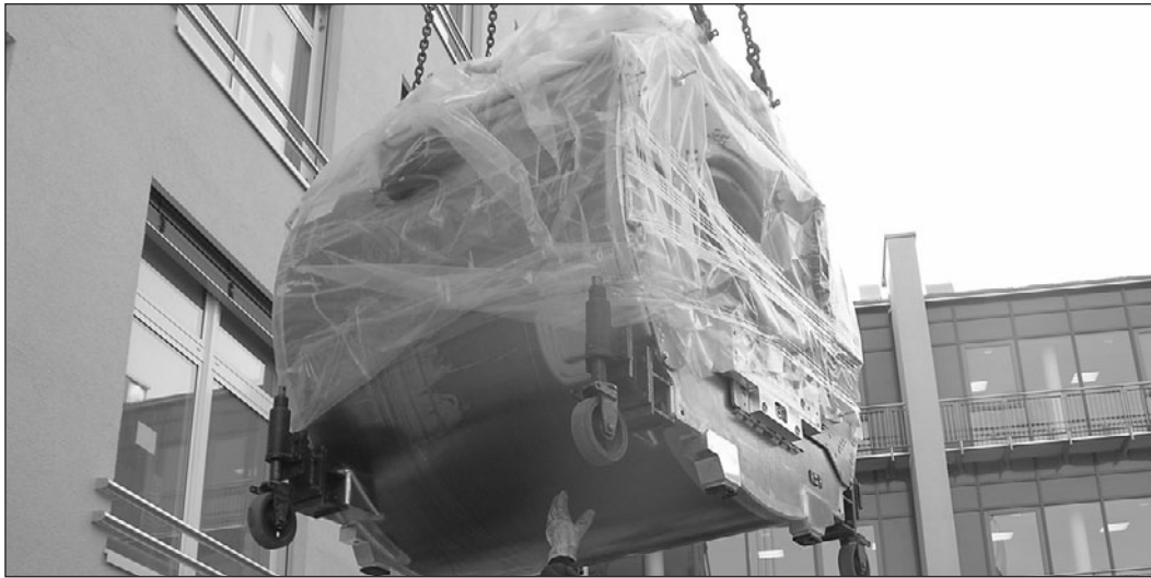
■ Per Kran wird der Kernspintomograph ins Ärztehaus am Opladener Remigius-Krankenhaus gehoben.
